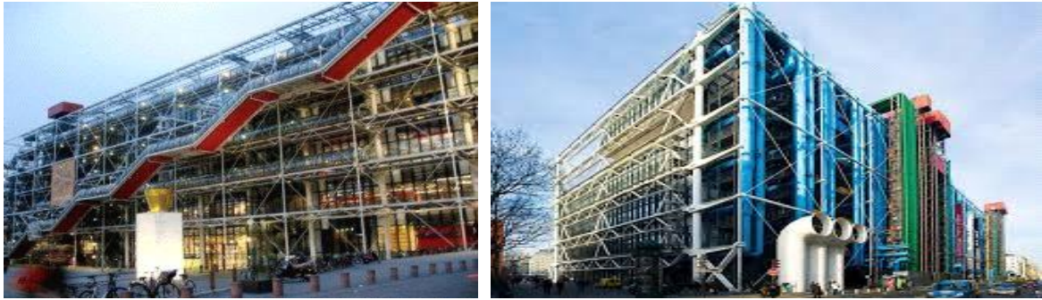
Рисунок 10 – Фасады Центра им. Жоржа Помпиду в Париже
