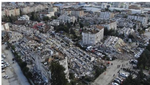
Рисунок 1. Последствия землетрясения в Турции 2023г.
