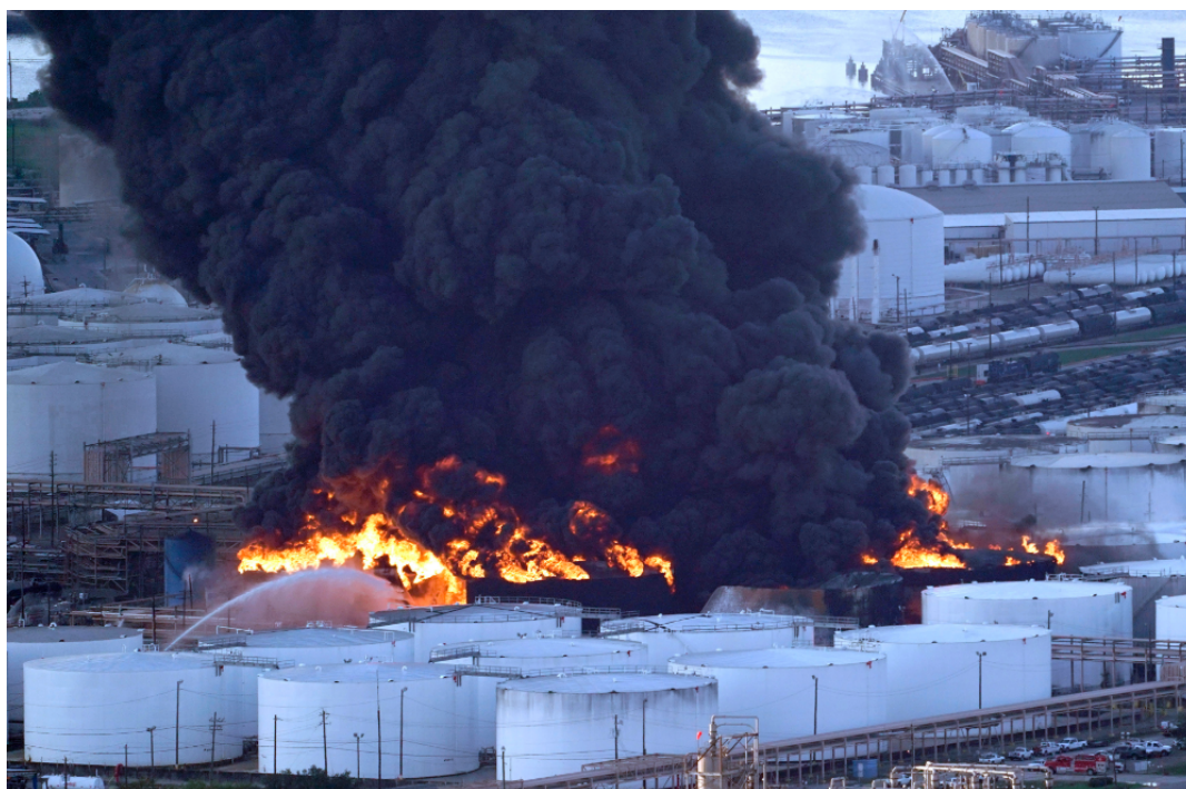
Рисунок 1 – Тушение пожара в резервуарах с горючими жидкостями
