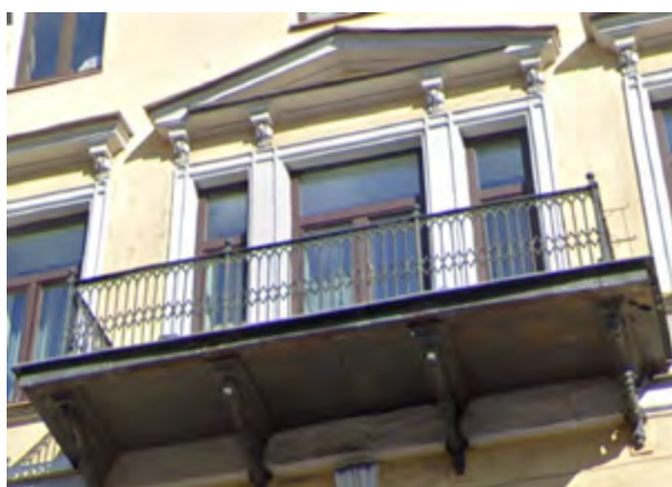
Ил. 6. Решетка балкона дома № 29 на ул. Миллионной
