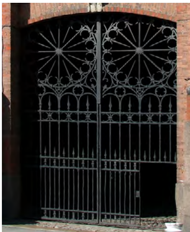
Ил. 7. Ворота здания Арсенала на Кронверке
