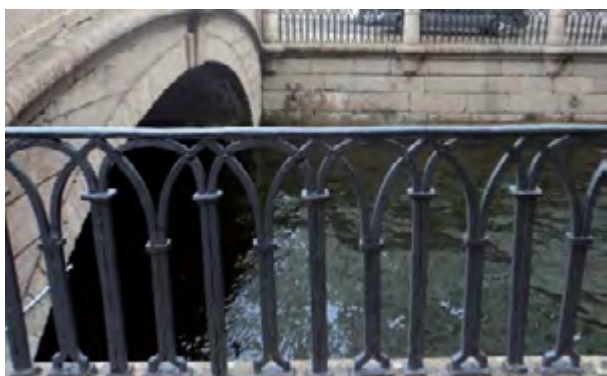
Ил. 4. Ограда набережной Зимней канавки.
