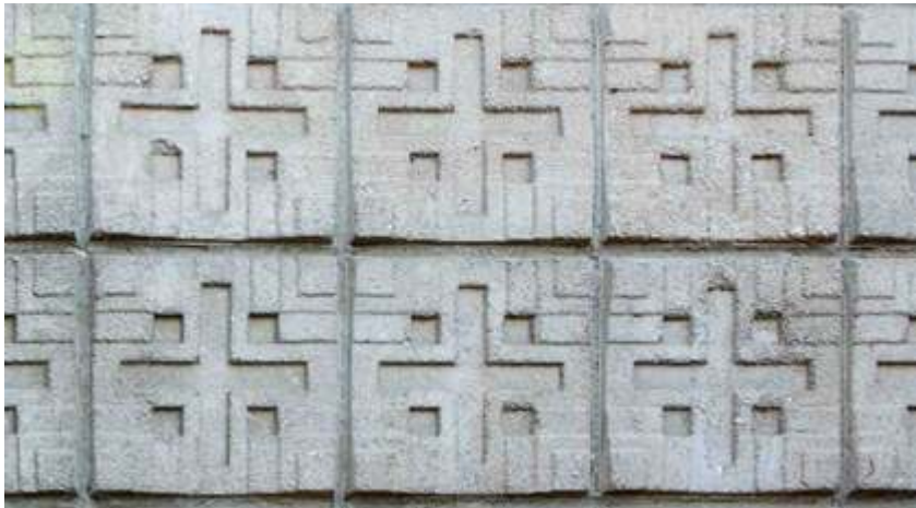
Ил. 2. Ф. Л. Райт. Текстильный бетон в решение Дома Миллард или «Миниатюра». Пасадена, Калифорния. 1923
