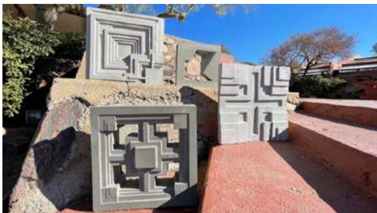
Илл. 1. Образцы текстильных бетонов Ф.Л. Райта
