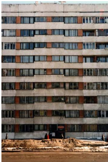
Рис. 4.14а. Первый продовольственный магазин, «врезанный» в типовую многоэтажку недалеко от станции метро Приморская, Санкт-Петербург, 1998 г.
