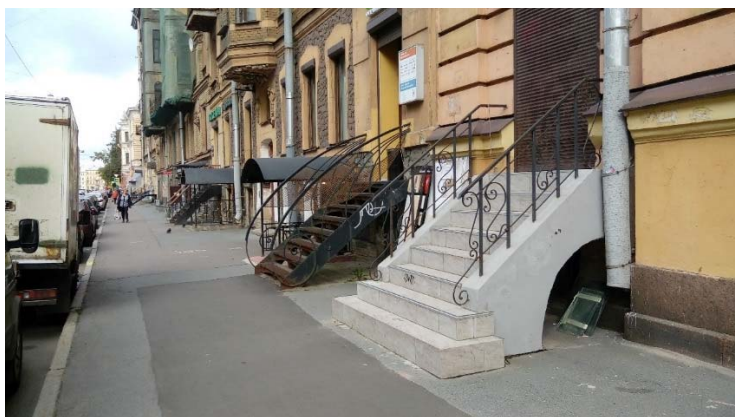
Рис. 4.16. Входы в предприятия ритейла, оборудованные в некогда оконных проемах некогда жилого здания в историческом центре города, Санкт-Петербург, 2018 г. Фото автора.
