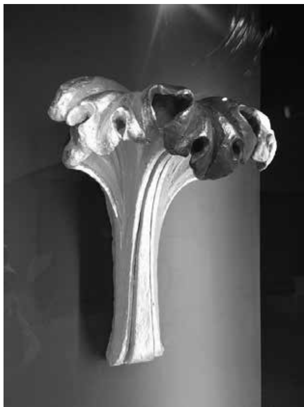
Рис. 2. Керамическое убранство здания Санкт-Петербургского губернского общества «Сплендид-Паллас». Караванная ул., д. 14, 1914 г. Архитектор К. С. Бобровский. Фрагмент. Фото автора.
