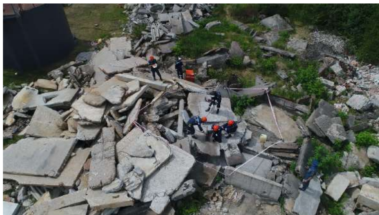
Рисунок 2 – Ведение работ по разбору завала панельного здания
