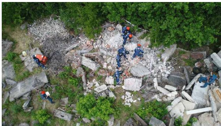
Рисунок 1 – Ведение работ по разбору завала кирпичного здания
