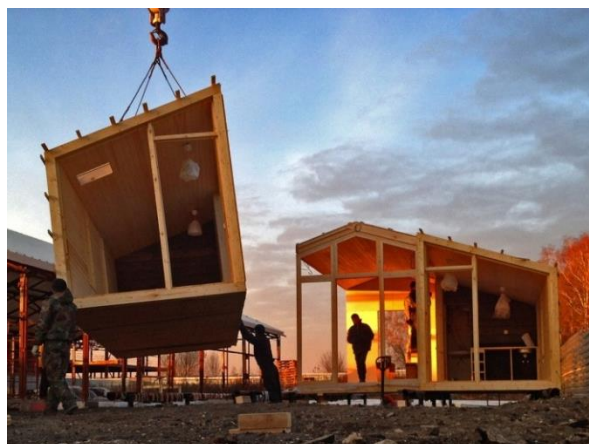
Рис. 2. Монтаж модульного дома на площадке
