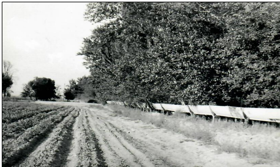
Рис. 5. Железобетонный лоток, облесённый с южной стороны
