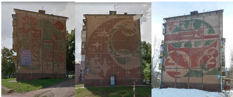
Рис. 8. Жилые здания №14, 22,30 на ул. Бульвар Космонавтов
