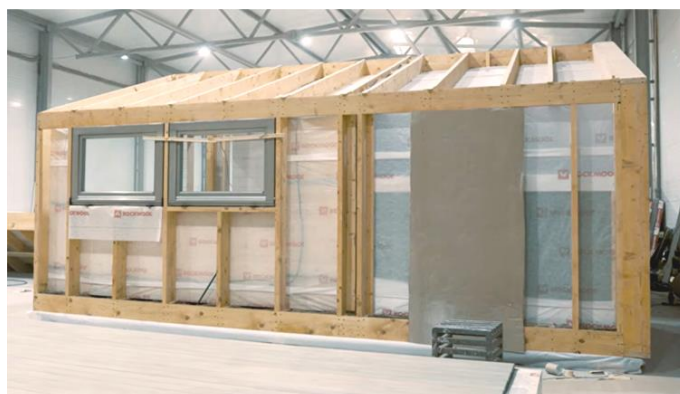
Рис. 1. Каркас модульного дома на производстве. ДубльДом
