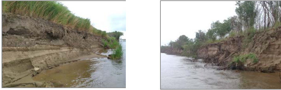
Рис. 2 Фотографии исследуемого участка, сделанные во время инженерных изысканий в 2020 г. АО «Транснефть – Подводсервис».
