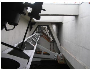
Рис. 3. Водопускной затвор (1 из 64) на комплексе защитных сооружений г. Санкт-Петербурга.
