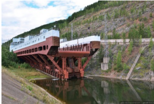
Рис. 2. Судовозная камера судоподъемника на реке Енисей в г. Дивногорске Красноярский край.
