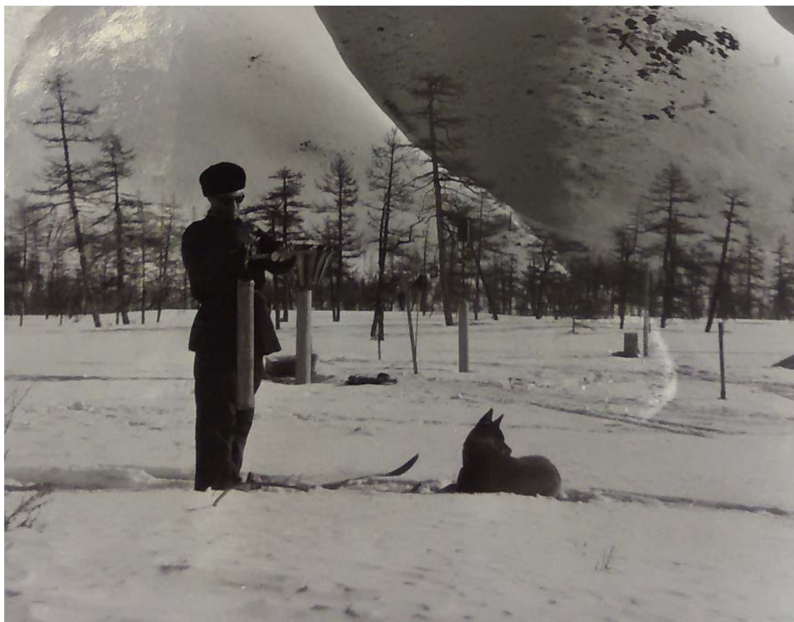
Рис. 16 Измерение плотности снега, 1960 г.
