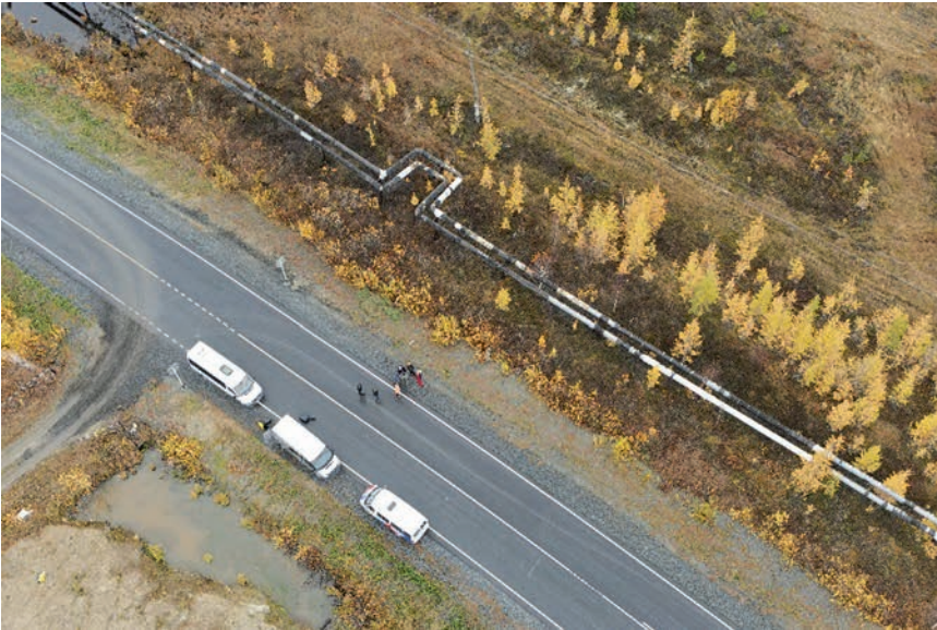
Рис. 20. Антропогенно спровоцированные обводнённые термокарстовые понижения вблизи дорожной насыпи и трубопровода.
