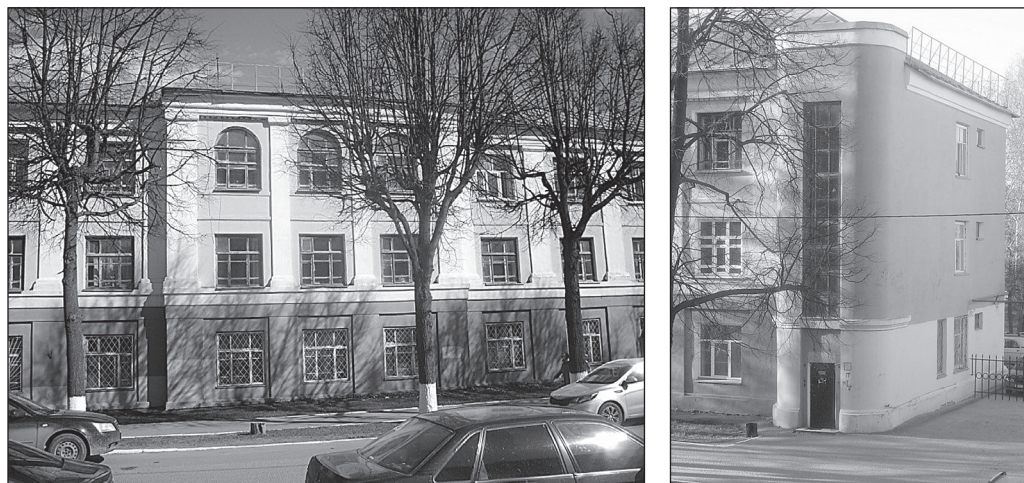
Рис. 11 Здание общежития Лесотехнического института. Фрагмент фасада (а). Лестничный ризалит (б)
