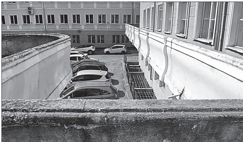
Рис. 10 Здание быв. Дома Советов. Фрагмент с ограждениями галерей-балконов
