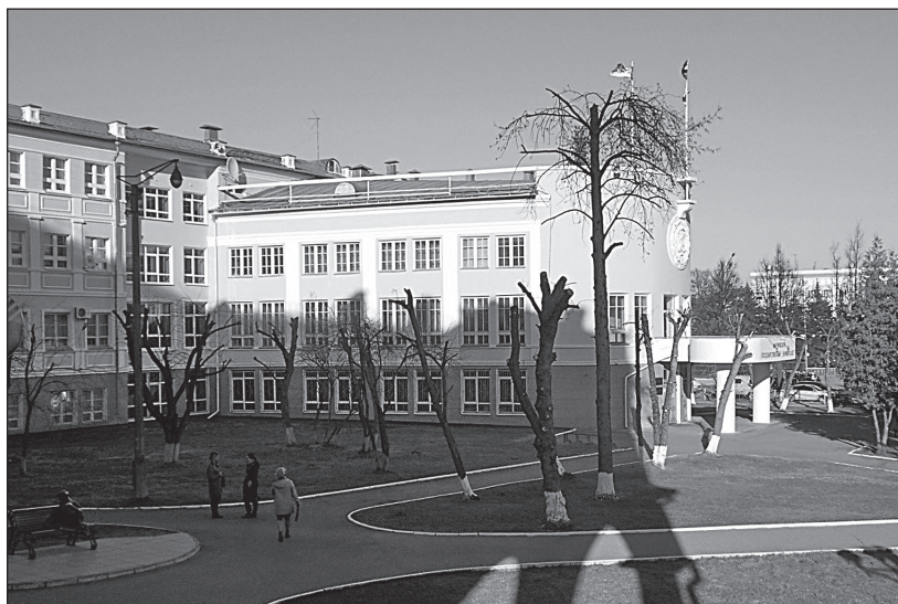
Рис. 9 Здание быв. Дома Советов. Фрагмент главного фасада
