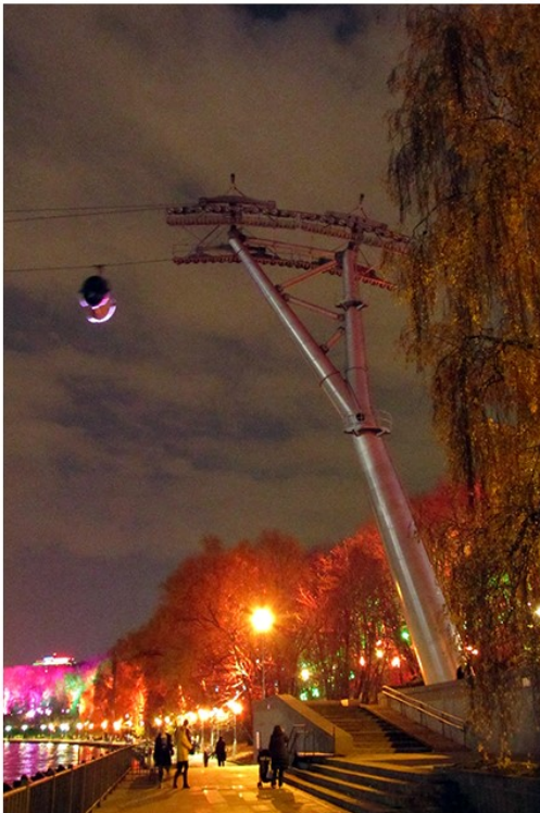
5–6. Опора канатной и вагончик дороги
