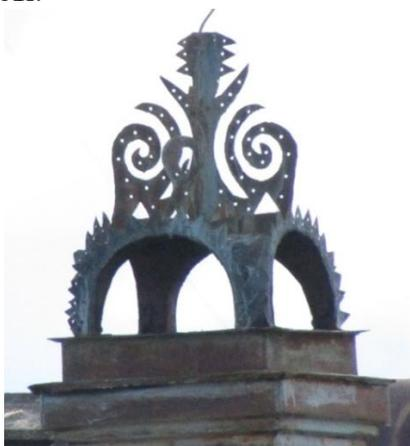
Рис. 3 – Металлический кованый дымоход, с. Чухчерема (д. Поташевская).
