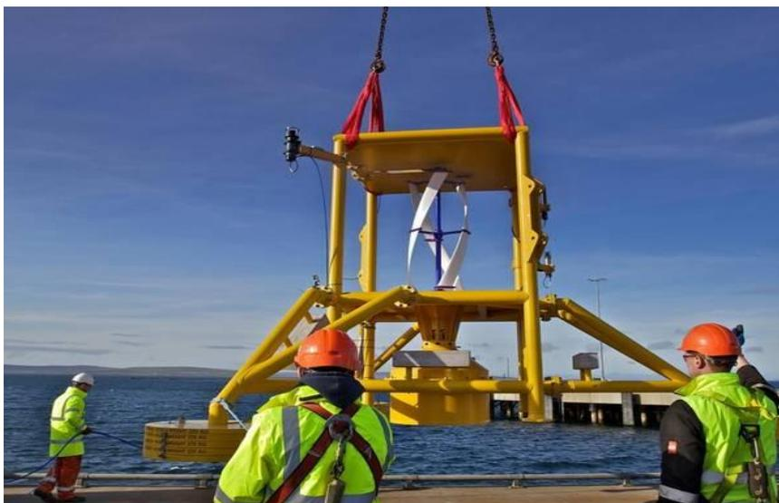
Рис. 2 – Плавучая установка приливной энергетики для энергоснабжения буровой платформы
