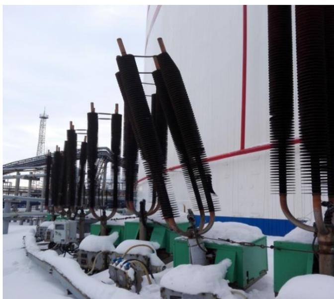
Рис. 2 – Термостабилизаторы на РВС-50000
