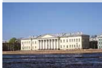
Здание Санкт-Петербургской академии наук на Васильевском острове
