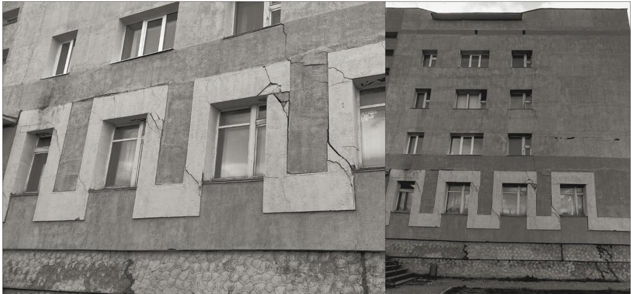
**Рис. 2. Трещины в стене дома в с. Лаврентия Чукотского АО (фото автора, 2021 г.)**
