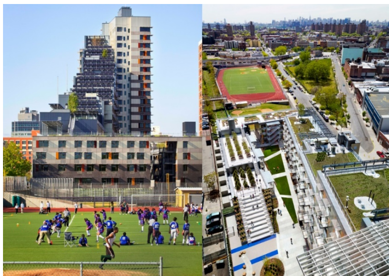
Рисунок 3 – Жилой комплекс Via Verde, архитектор Николас Гримшо, реализация 2011 г, фотографии взяты с сайта www.archi.ru
