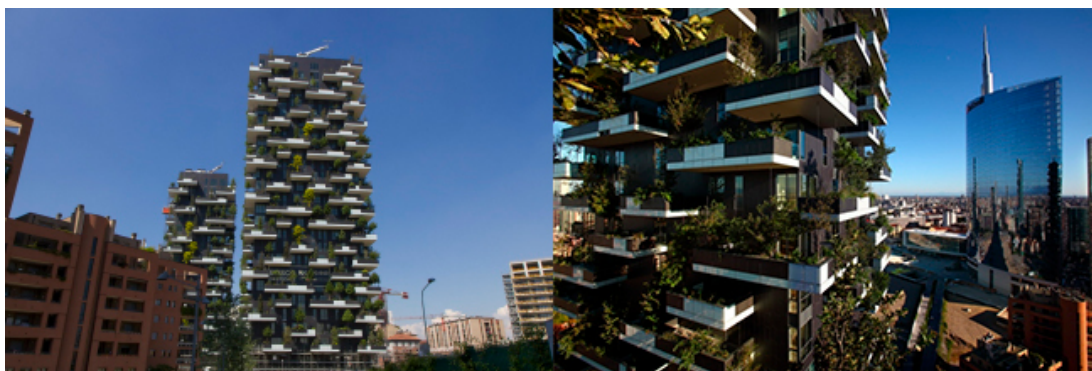
Рисунок 2 – Жилой комплекс Bosco Verticale, архитектор Стефано Боэри, реализация 2013 г, фотографии взяты с сайта www.archi.ru
