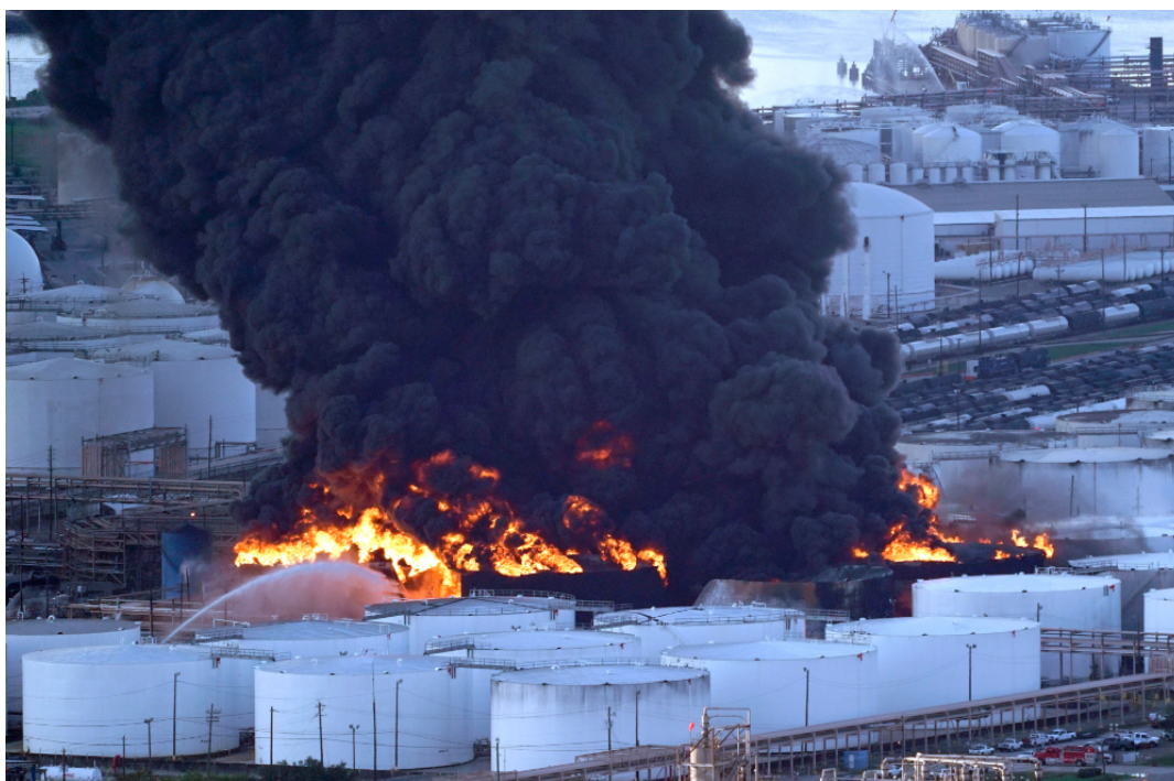
Рисунок 1 – Тушение пожара в резервуарах с горючими жидкостями
