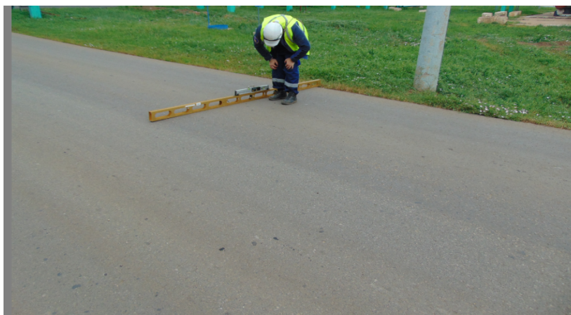
Рисунок 1 – Измерение угла водоотвода покрытия автомобильной дороги, показателя ровности поверхности (плоскостности)
