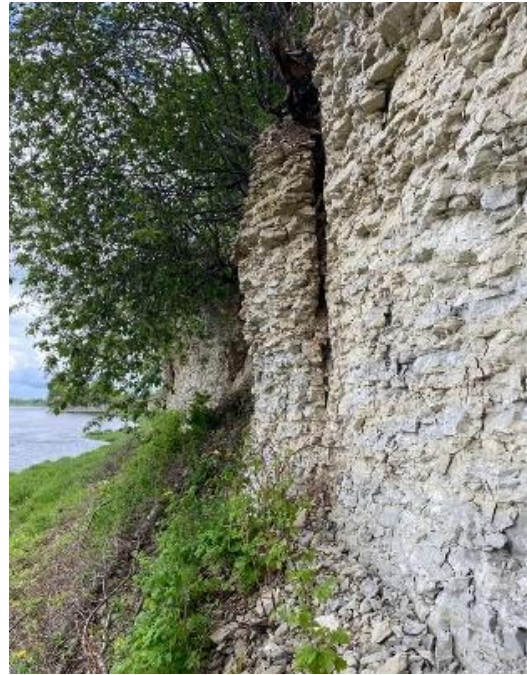
Рис. 3. Заполнение трещины дресвяно-щебнистым материалом
