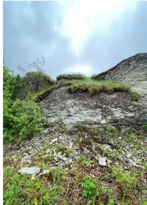
Рис. 5. Вид на тело старого оползня на левом берегу р. Великой
