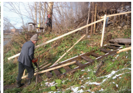
Ремонт поручней лестницы на Университетском озере. Ноябрь 2015 г.
