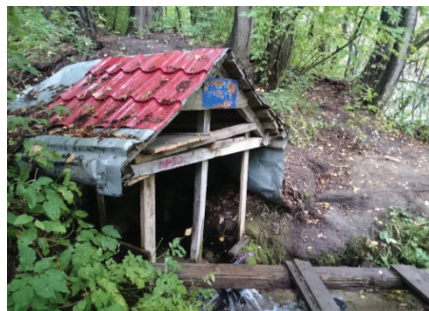
Последствия регулярного вандализма: вырваны все лотки, сорваны таблички, разрушен мостик. Август 2015 г.
