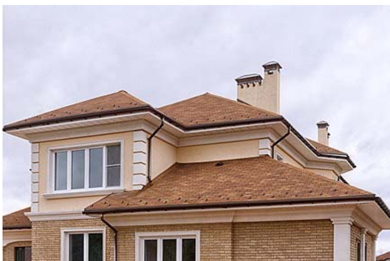
Рис. 1 Вид крыши, перекрытой битумной черепицей
