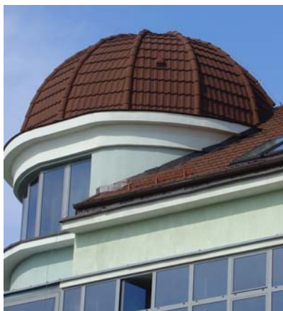
Рис. 3 Купольный фрагмент крыши из композитной черепицы
