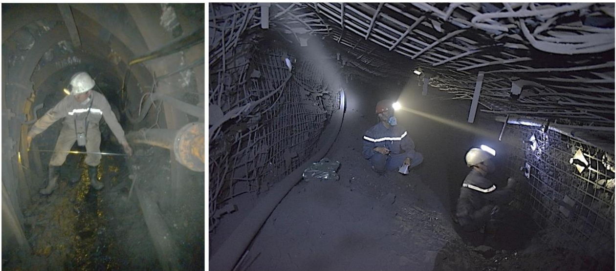
Рис. 3. Наблюдение деформации повторно используемых подготовительных выработок на шахте «Хечам» [2]
