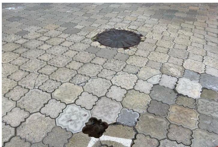
Рис. 1. Суффозионная воронка на территории ПГНИУ вблизи корпуса № 8
