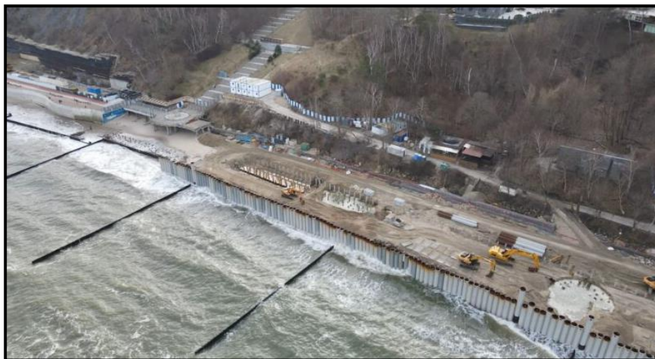
Рис. 9. Строительство пляжеудерживающих сооружений в Светлогорске
