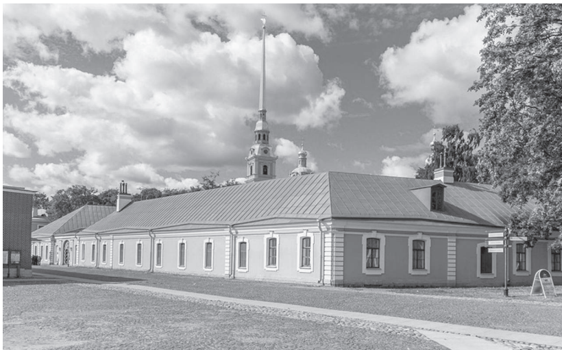
Инженерный дом в Петропавловской крепости. Современный снимок
