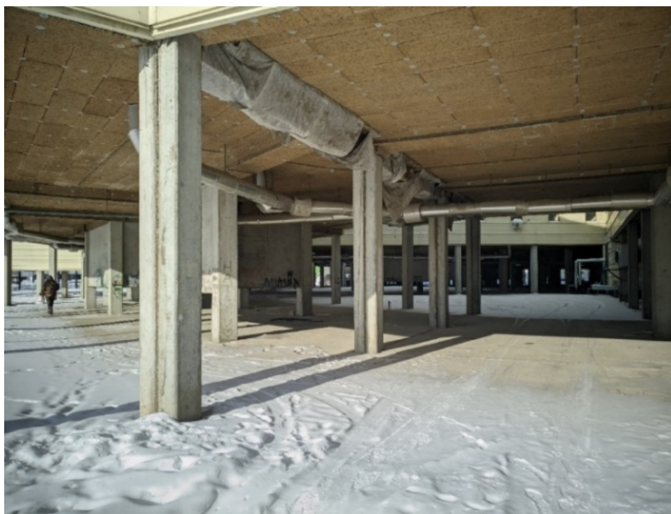
Рисунок 1. Проветриваемое подполье клинико-диагностического центра высотой 4,5–5 м.
