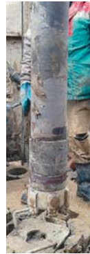
Рисунок 2 — Долото + обсадная колонна
