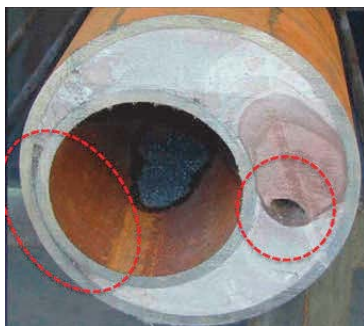
Рисунок 1 — Пример некачественного цементирования обсадной колонны
