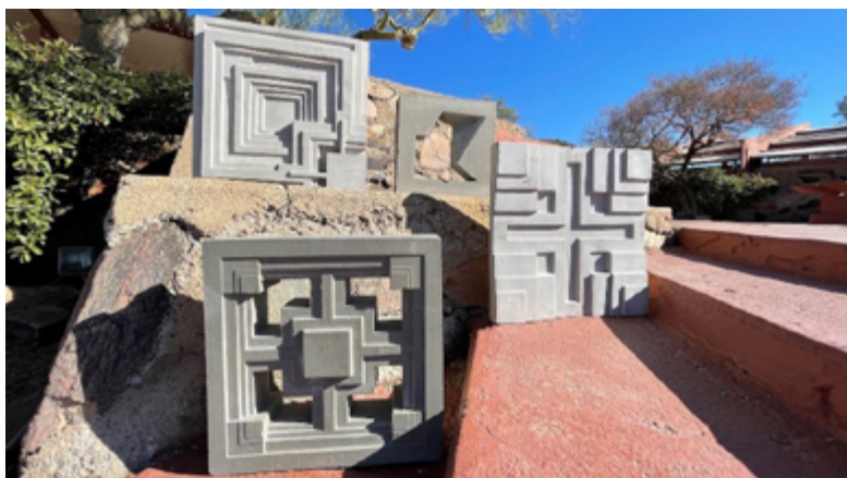
Илл. 1. Образцы текстильных бетонов Ф.Л. Райта
