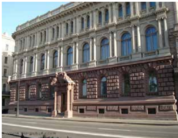
Ил. 1. Дворец Вел. кн. Михаила Михайловича. Вид фасада со стороны Адмиралтейской наб.
