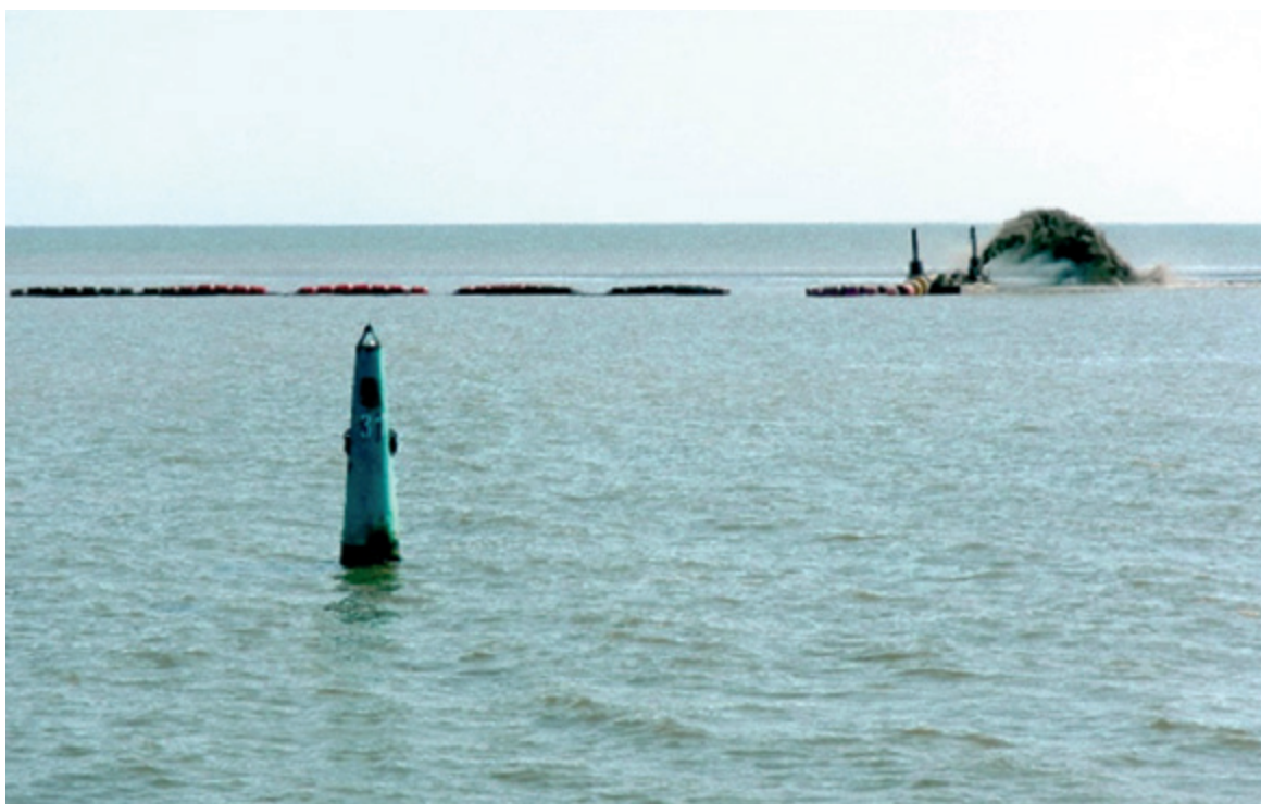
Рис. 3. Сизифов труд. Изъятый в морской части канала грунт вскоре вновь попадет в ложе канала под воздействием течений, волнения и дрейфующих льдов (фото П.И. Бухарицина)
