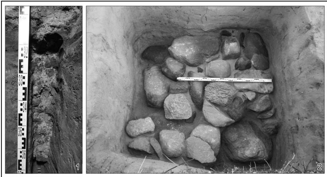
Рис. 4. Фундаменты новгородских храмов рубежа XIII—XIV вв.: 1 — церковь Николы на Липне. 1292. Северо-западный столб; 2 — церковь Покрова Шилова монастыря. 1310. Юго-западный столб (фото автора).
