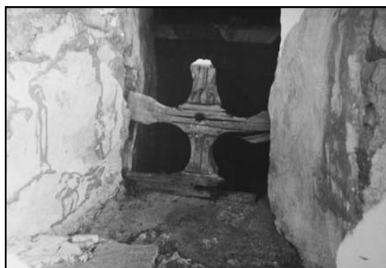
Рис. 10. Церковь Николая на Липне. 1292. Фрагмент наборной оконницы в южном окне апсиды (фотография 1950-х гг. Архив ННРУ, №7111/5972).
