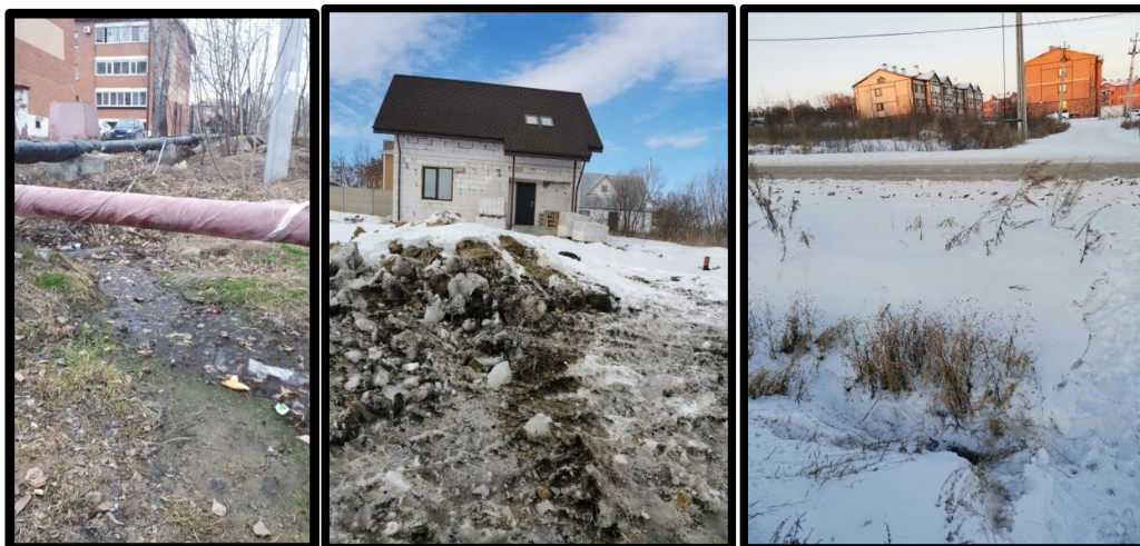
Рисунок 9 - выходы подземных вод в местах преобразования склоновых наносов
