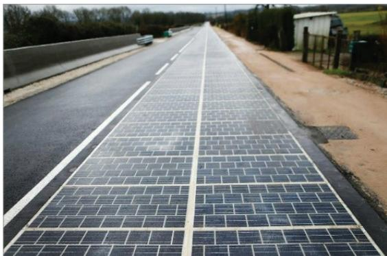
Рис. 2. Дорожное полотно с солнечными элементами, г. Турувр-о-Перш, Франция.
