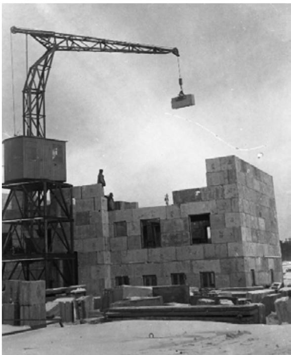
Рис. 2. Постройка Опытного дома № 6 из стандартных частей, 1930 год. ГАСО
