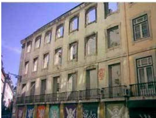
Рис. 2. Здание Помбалино. Gaiola Pombalina полностью разрушена. К сохраненному главному фасаду будет построена железобетонная конструкция. В этом виде здание потеряет свою аутентичность. Фото С. Ивановой-Морайш
