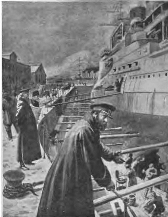
Рисунок 2. Заделка пробоин судо в сухом доке в Порт-Аргуре. [Нива, 1904, №9, с. 178].
