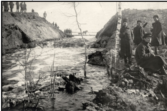
Илл. 1. Прорыв плотины в апреле 1881г.
