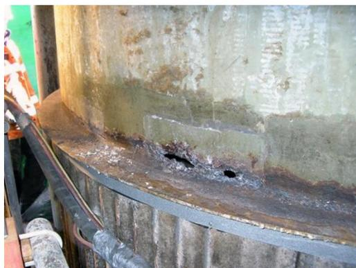
Рисунок 1 - Сквозная коррозия стенки в основании резервуара
