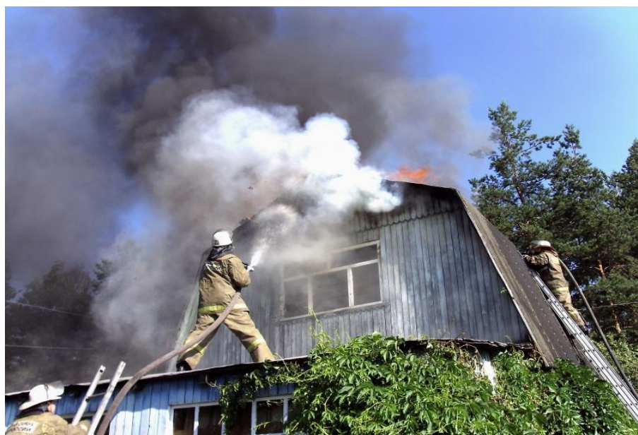
Рис. 1. Тушение пожара частного домовладения
