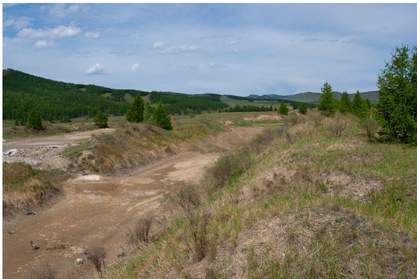
Рис.4. Насыпная траншея, профили проходят вкрест простирания.
