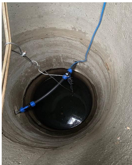
Рис. 1. Вид внутри колодца
