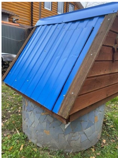
Рис. 2. Вид снаружи колодца
