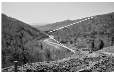
Рис.1. Укладка трубопровода в селевом русле реки Пулька
