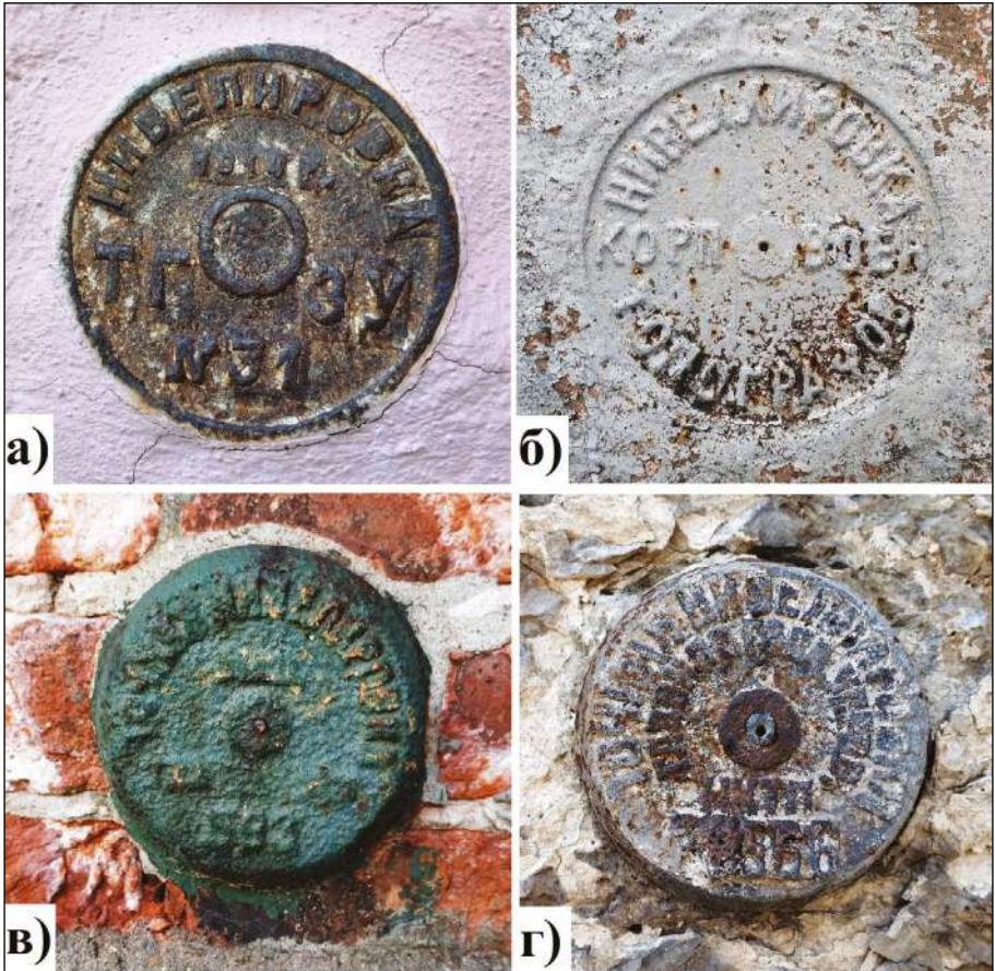
Рис. 9. Выявленные на территории Тульской губернии нивелирные марки разных типов: а – Тульского губернского земского управления 1914 г., б – Корпуса военных топографов 1928 г., в – Высшего геодезического управления (1924 г.), г – Главного геодезического управления (1932 г.).
