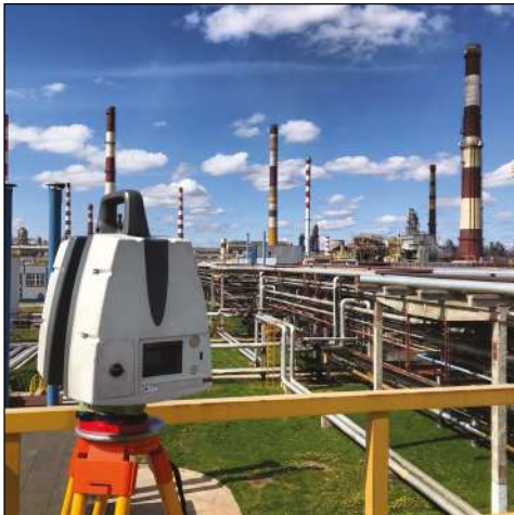
Рис. 4. Выполнение наземного лазерного сканирование промышленного объекта для разработки проекта реконструкции
