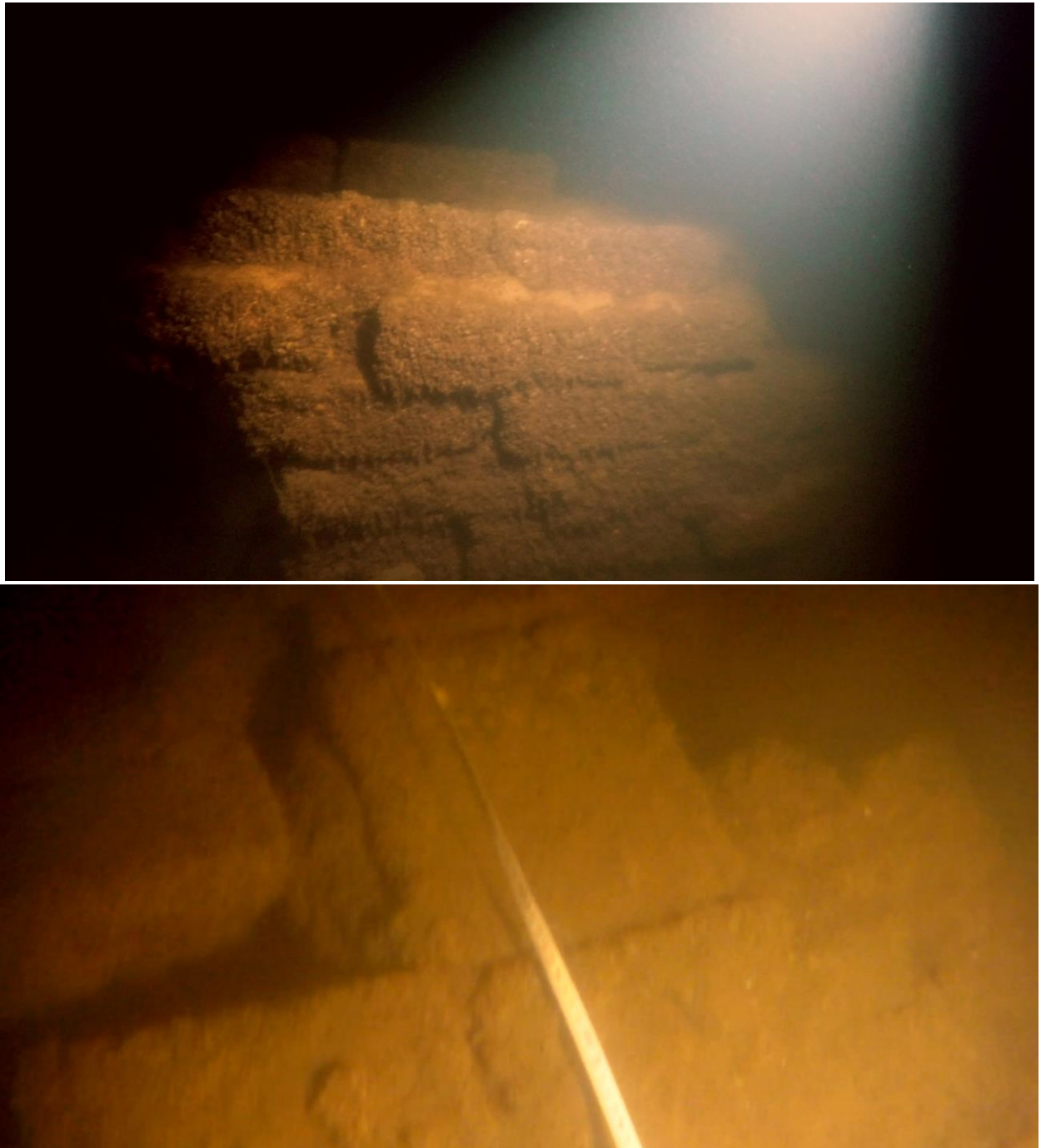
Рис. 6. Здание II под водой
