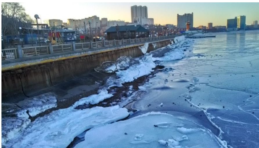
Рис.2. Волноотбойная стенка на набережной г. Владивостока. Фото А.В. Малюгина
