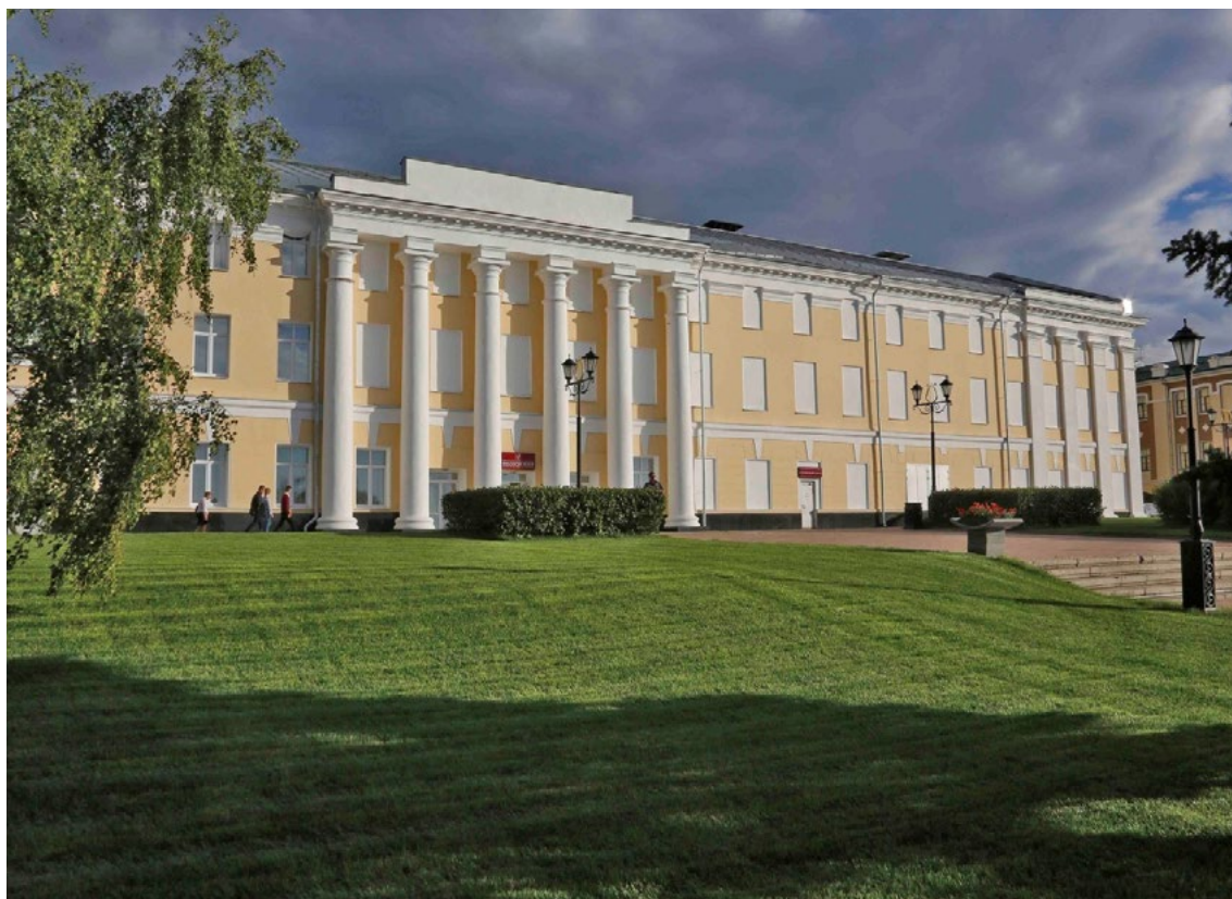
Рис. 4. Реставрация и приспособление для современного использования Здания Присутственных мест (Нижегородский Кремль, корпус 2).
